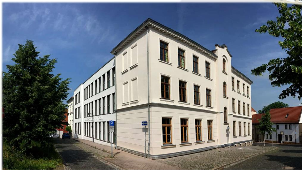
Ersatzneubau Geschwister-Scholl-Gymnasium Taucha
